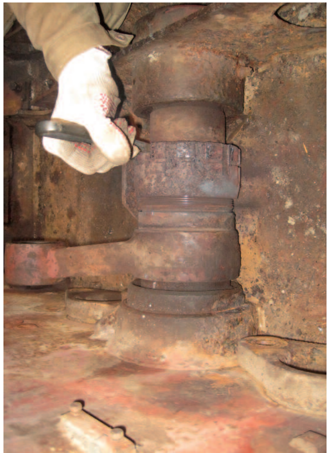
Nun muss noch die Überwurfmutter gelöst werden.
