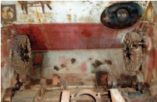
Frontbereich der Wanne innen, Zustand Sommer 2010
